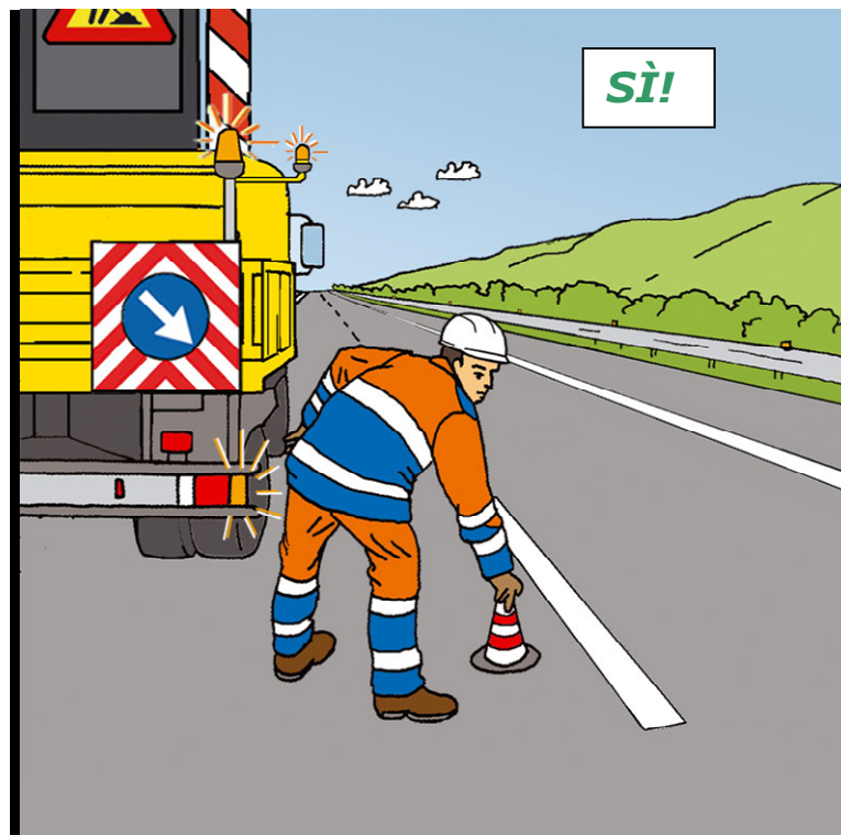
Figura 59 – Posizionamento dei coni o defleco: comportamento corretto
