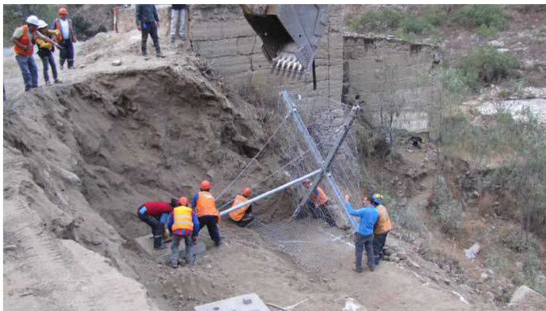
Foto 4- esempio installazione barriere
