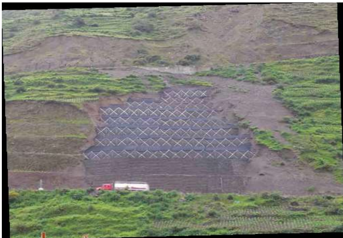
Foto 5- Esempio di consolidamento versante con barriere Erdox
