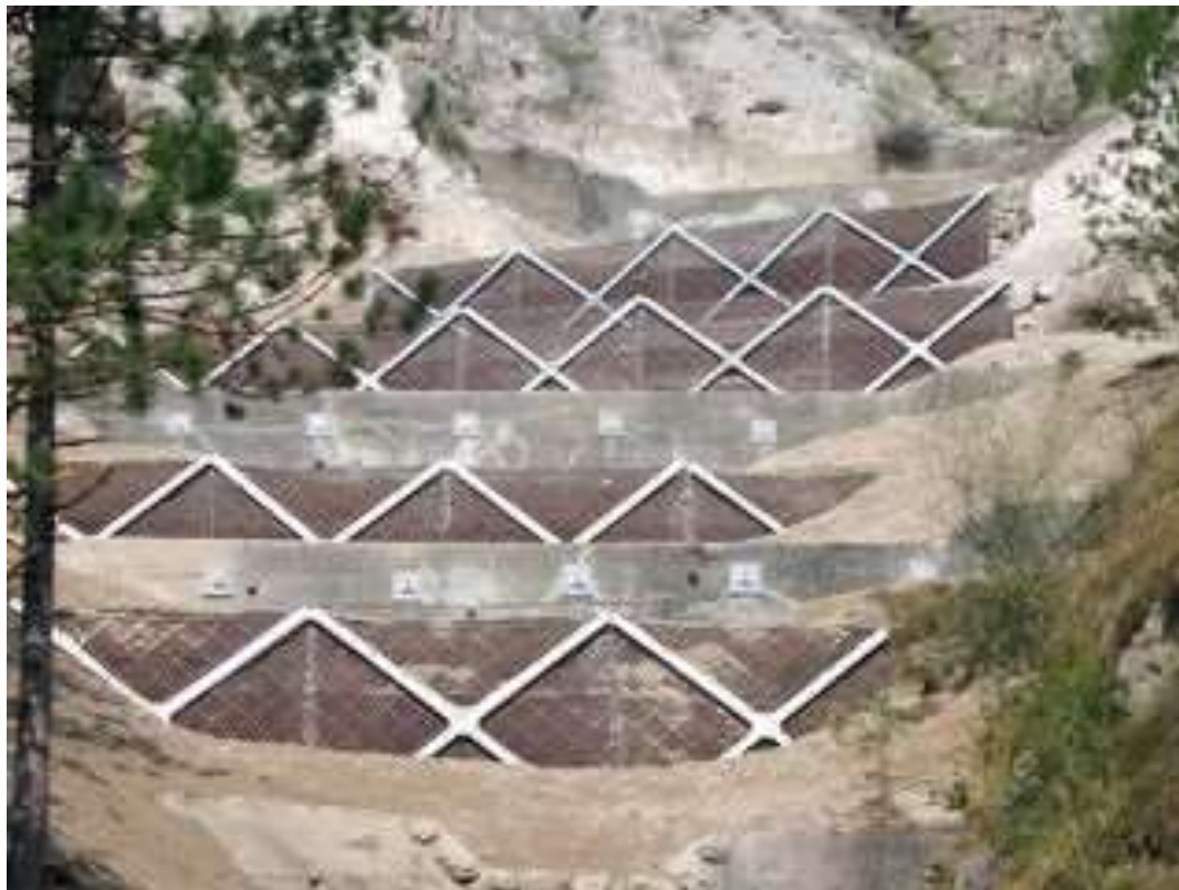
Foto 3- esempio di barriere tipo Erdox di contenimento già installate altrove
