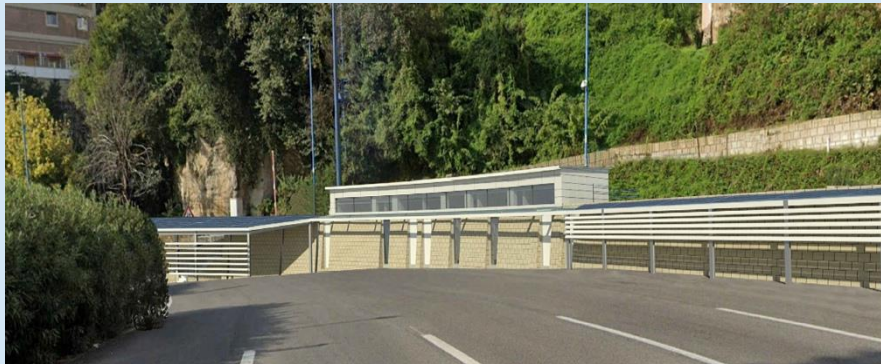
Fotoinserimento post intervento
